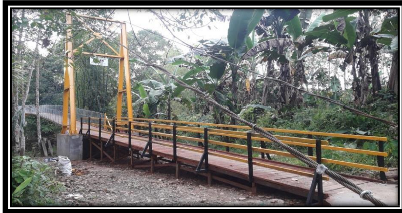
Pembangunan jembatan gantung Bipak Desa Balida
